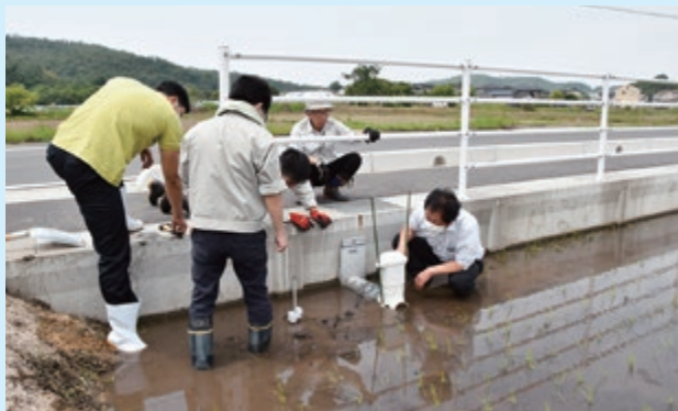
取付作業の様子
