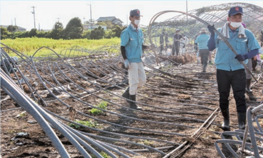
ハウスの撤去作業に汗を流すJA広島中央の職員
